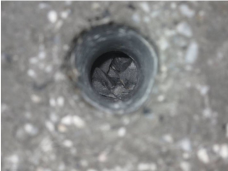
图4 钻孔塌孔
