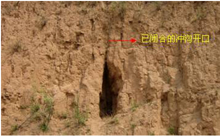
图4 野外现场调查中“腔体”底部坍塌
