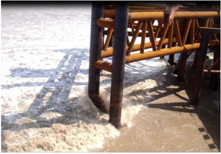
图 4 涌潮通过大桥时的照片
