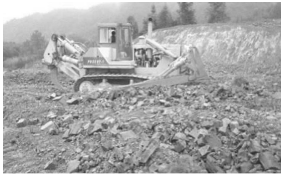
图1 宕渣路基填筑
