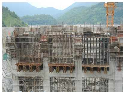
图4 贝雷片+钢管脚手架支撑系统效果
