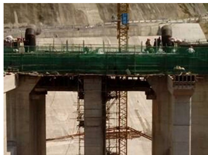
图2 型钢+钢管脚手架承重系统效果
