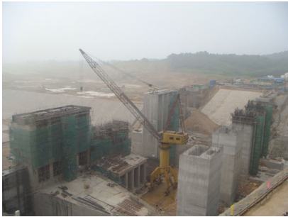
图2 施工阶段门机布置示意图
