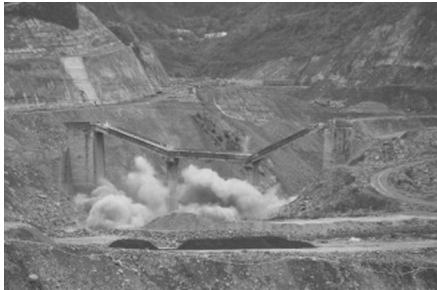
图 6 拆除爆破倒塌瞬间
