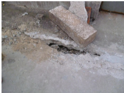
图2 沉降裂缝
