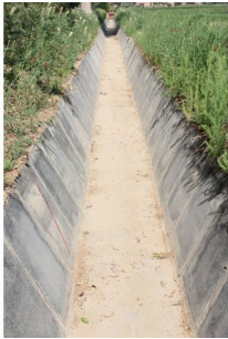
图 1 渠道衬砌断面
