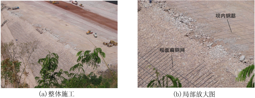
图3 糯扎渡心墙堆石坝抗震钢筋现场施工
