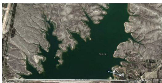
(a) 水库取水塔
