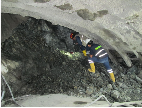
图 10 顶拱扩挖支护后情况
