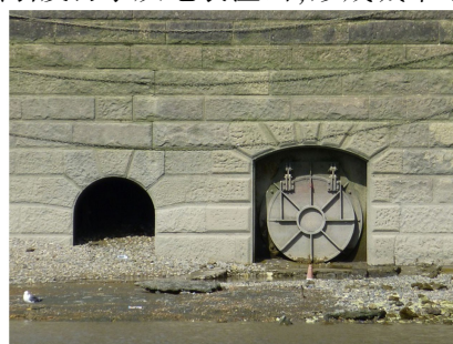
(a) 维多利亚时代下水道 [20]
