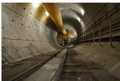
(b) 已建成的Lee Tunnel [20]
