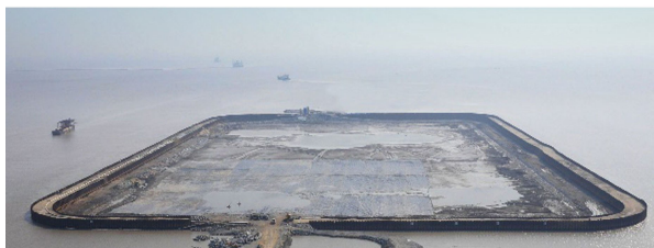
图2 水闸围堰实景鸟瞰图
