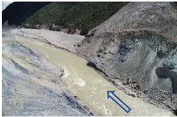
(a) 泄流槽右岸边坡
