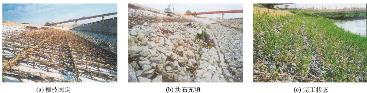
图3 柳枝工工法施工实例 [18]
