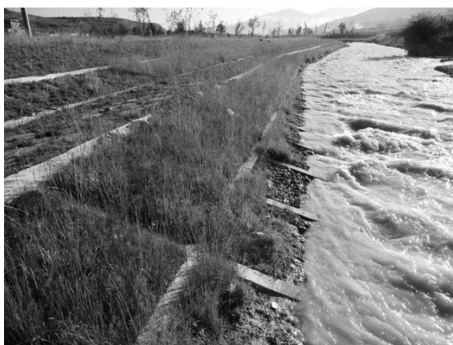
图 4 格宾石笼+生态混凝土护坡设计及实施效果
