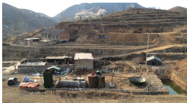
(b) 修复工程现场
