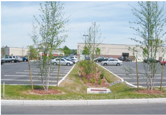
图 5 停车场低影响开发措施示意图
