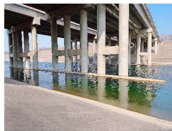
(b) 10柱阻水桥柱
