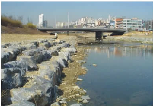
图2 自然石积护岸(施工初期)
