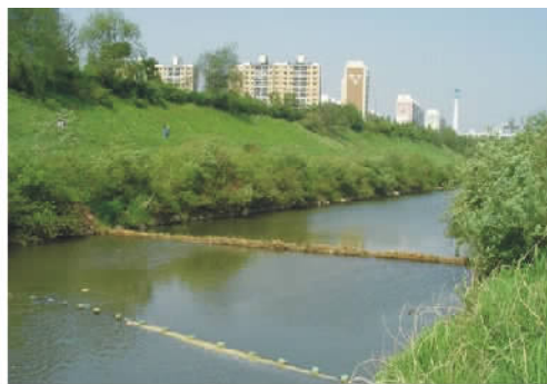
图3 自然石积护岸(施工后第3年)
