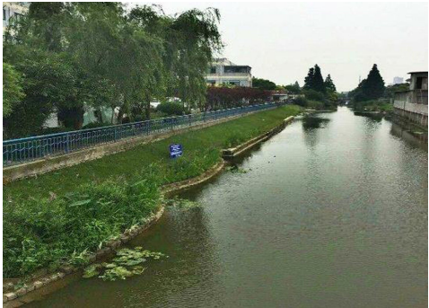
图4 河道护岸生态设计中试工程实景
